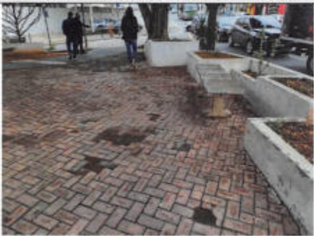
FOTO 05 – PISO A SER RETIRADO E DEMOLIDO
