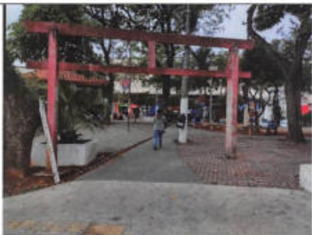
FOTO 01 – PORTAL TORII EXISTENTE A REFORMAR
