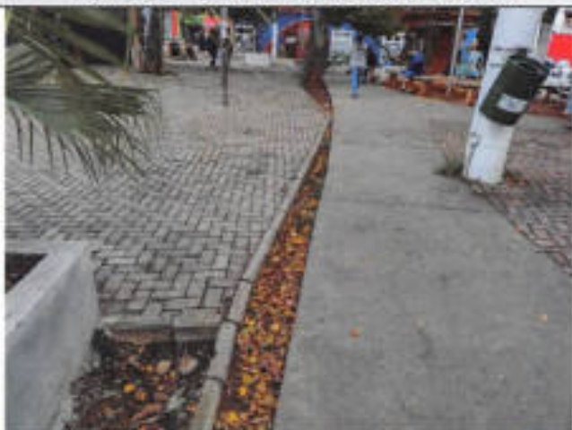
FOTO 04 – PISO A SER RETIRADO E DEMOLIDO
