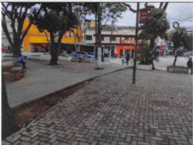
FOTO 03 – PISO A SER RETIRADO E DEMOLIDO
